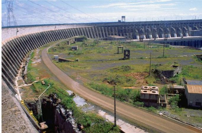
Abb. 17 Die Staumauer hält dem Wasserdruck alleine durch ihr Eigengewicht stand und ist 7.7 Kilometer lang. (Quelle: [www.corbis.com](http://www.corbis.com))
