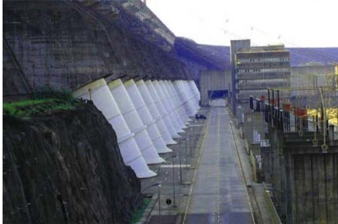
Abb. 14 Staumauer mit den weissen Druckrohren (Quelle: [www.portalfoz.com.br](http://www.portalfoz.com.br))
